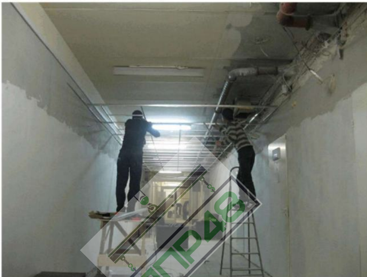
Рисунок 14. Установка каркаса
