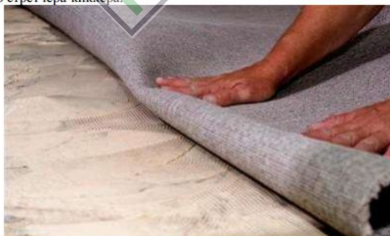
Рисунок 3. Укладка ковролина
