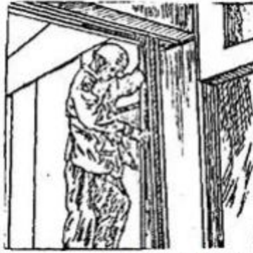
Рисунок 7. Установка стойки по отвесу
