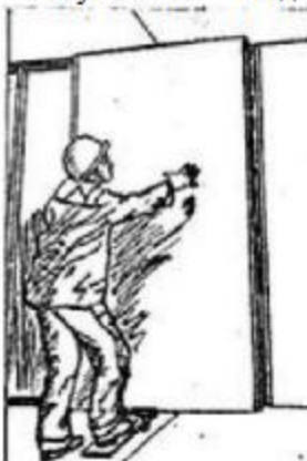
Рисунок 11. Установка листа в проектное положение с помощью подножки
