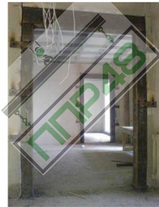
Рисунок 36. Усиление проема
