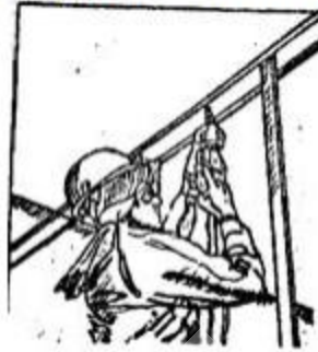
Рисунок 4. Пристрелка верхней направляющей
