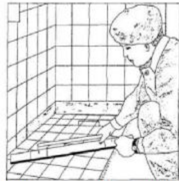
Рисунок 21. Осаживание плитки полутерком
