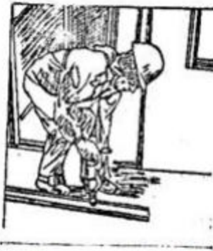
Рисунок 3. Пристрелка нижней направляющей
