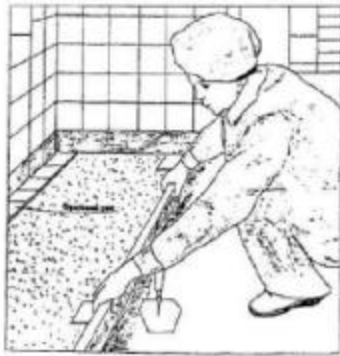
Рисунок 18. Разравнивание раствора рейкой по маякам
