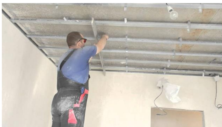
Демонтаж каркаса
