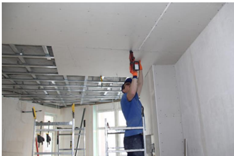
Демонтаж гипсовых листов
