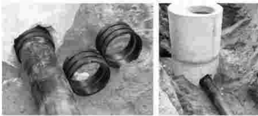
Защитные муфты для входа в бетонный колодец
