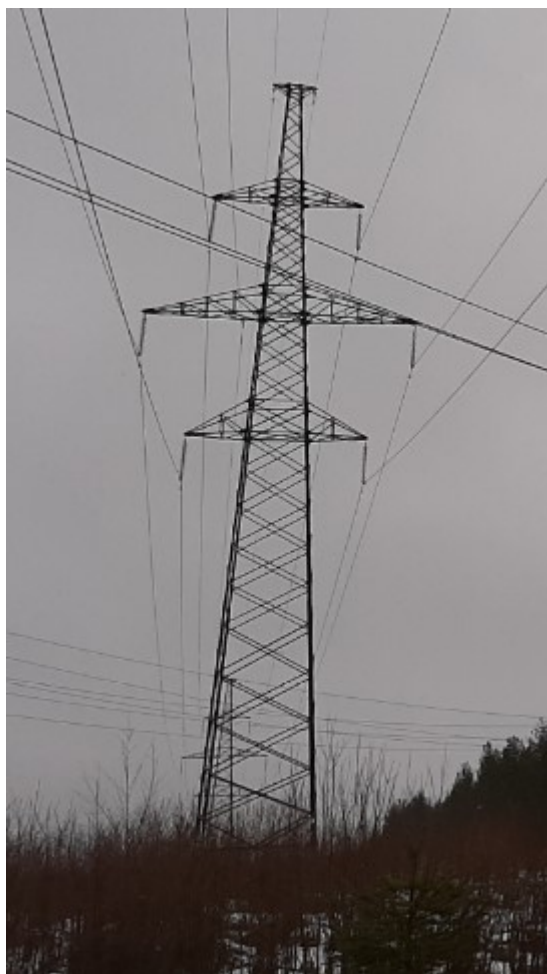
Рисунок 4. Общий вид опоры ВЛ-220 кВ
